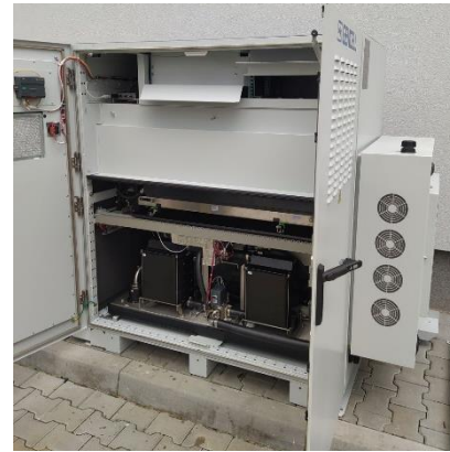
Jednotky ohřevu vzduchu a absorpce CO 2
