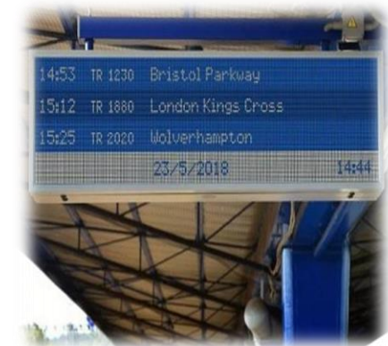
Off- grid informační systémy a osvětlení
